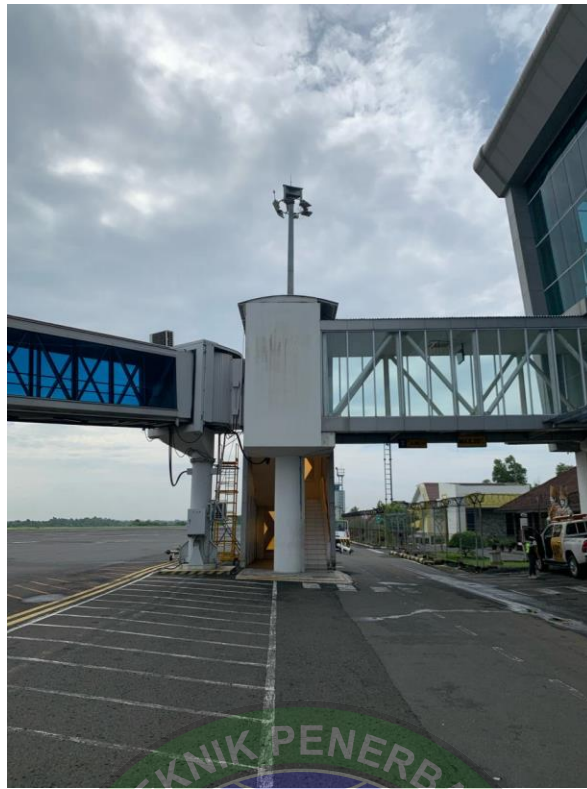
Gambar 4.1 Bangunan yang memotong Service Road
