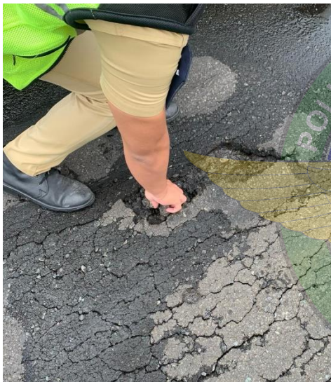
Inspeksi runway pada Kawasan Apron
