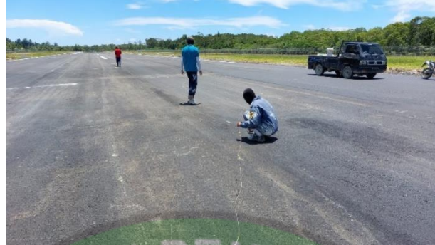
Gambar 4.25 Pembuatan Sketsa Marka Sumber: Olahan Penulis, 2023
