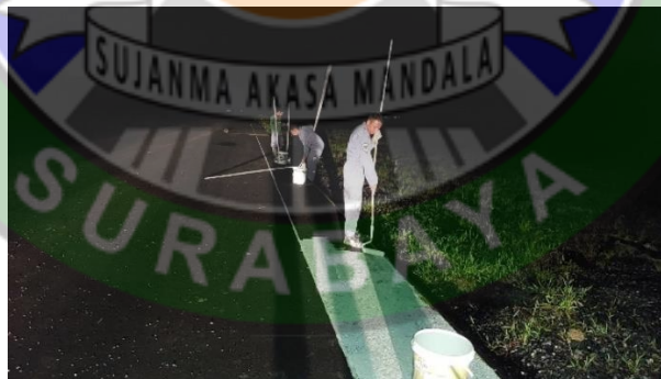
Gambar 4.26 Pengecatan dengan Rol Sumber: Olahan Penulis, 2023
