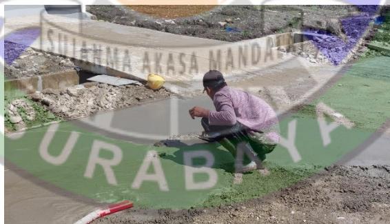
Gambar 4.42 Penuangan Adonan Semen Sumber: Olahan Penulis, 2023
