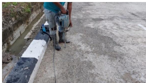
Gambar 4.40 Pembongkaran Beton Menggunakan Jack Hammer Sumber: Olahan Penulis, 2023
