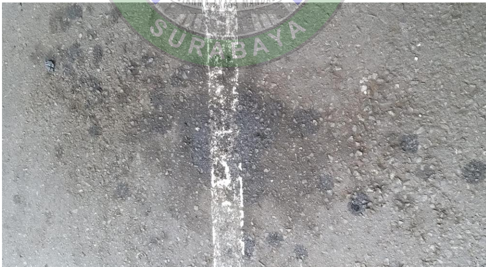
Gambar 4.2 Tetesan oli dari Ground Support Equipment .
