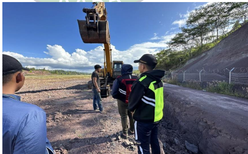
Gambar 4.11 Penggalian Tanah Menggubakan Excavator
