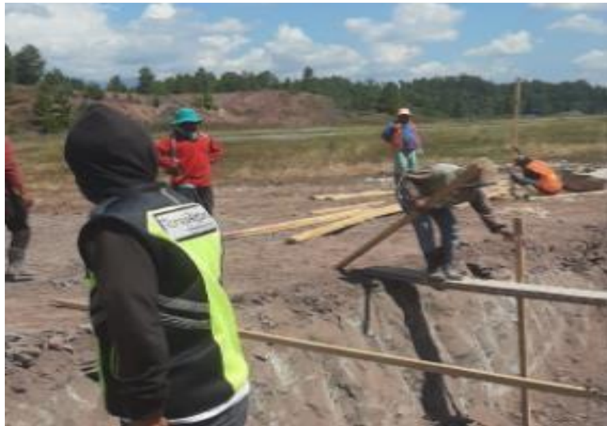
Gambar 4.13 Proses Pemasangan Bouplank
