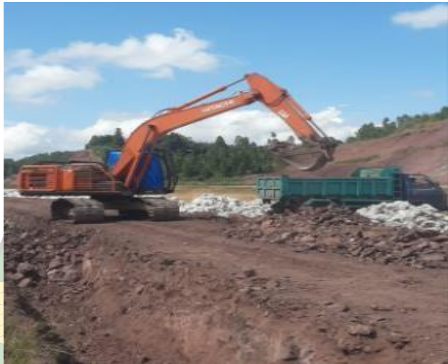
Gambar 4.12 Pembuangan Material Tanah
