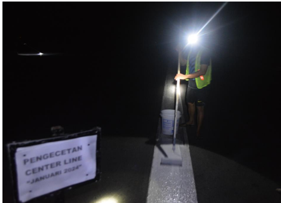
Gambar 4. 13 Proses Pengecatan Marka Center Line Sumber : Dokumentasi Penulis
