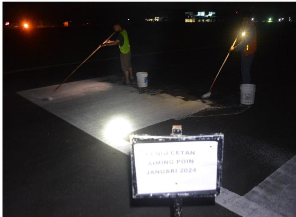
Gambar 4. 11 Proses Pengecatan Marka Aiming Poin Sumber : Dokumentasi Penulis
