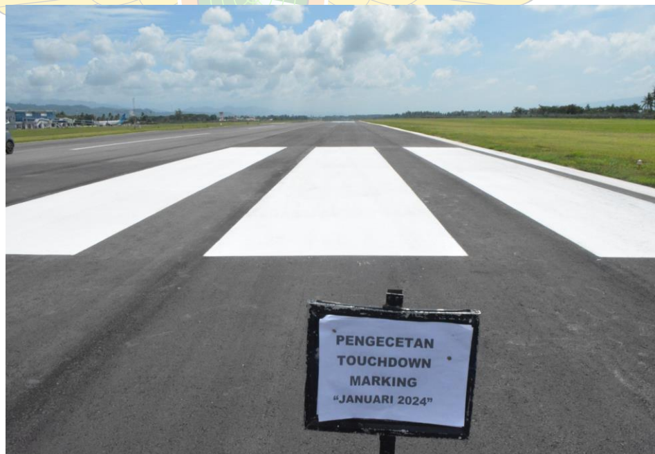
Gambar 4. 16 Hasil Pengecatan Marka Touchdown Zone Sumber : Dokumentasi Penulis
