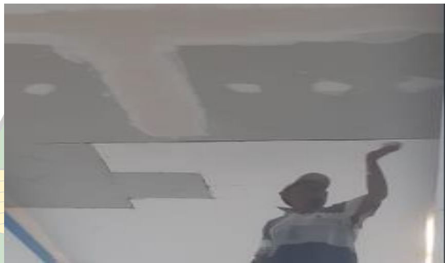
Gambar 4. 21 Proses Pelapisan Cornice Pada Gypsum Sumber : Dokumentasi Penulis
