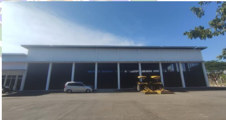
Gambar 4. 9 Gedung Alat-Alat Berat Sumber : Dokumentasi Penulis
