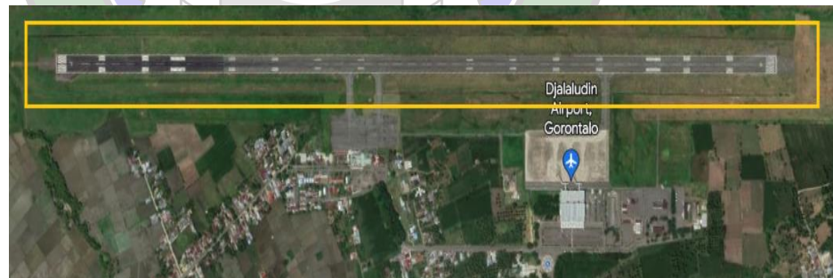
Gambar 4. 4 View Runway Strip Bandar Udara Djalaluddin Gorontalo
