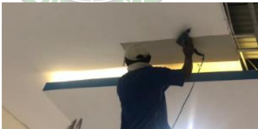
Gambar 4. 20 Proses Pemasangan Gypsum
