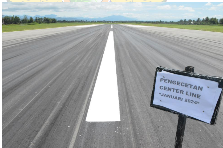
Gambar 4. 14 Hasil Pengecatan Marka Center Line Sumber : Dokumentasi Penulis
