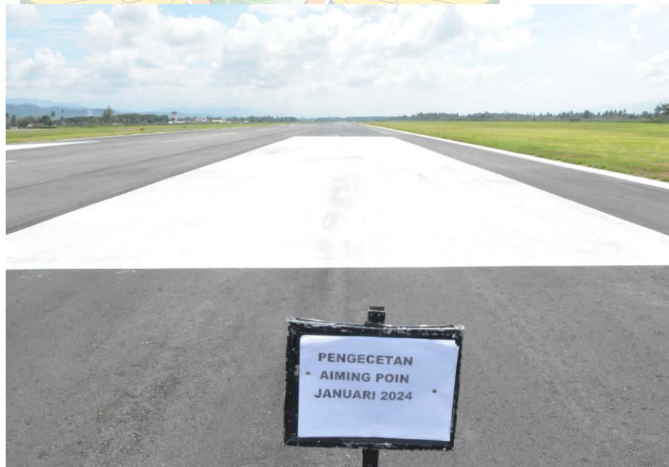
Gambar 4. 12 Hasil Pengecatan Marka Aiming Poin Sumber : Dokumentasi Penulis
