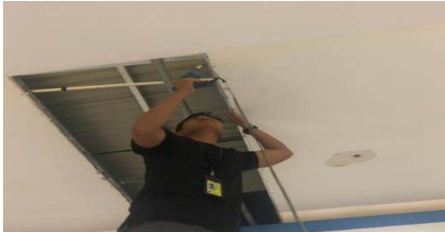
Gambar 4. 19 Proses Pemasangan Tulangan Baja Ringan
