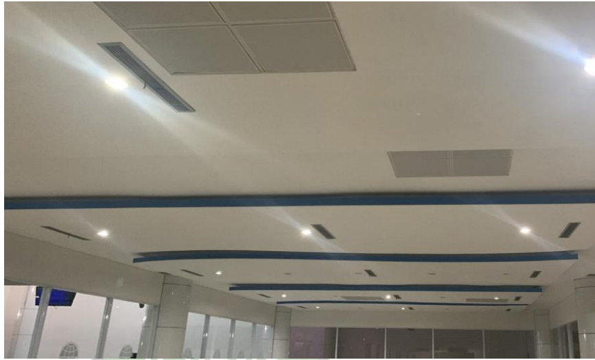
Gambar 4. 22 Hasil Perbaikan Pada Plafon Area Ruang Tunggu
