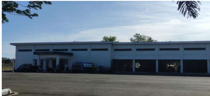
Gambar 4.12 Gedung Power House (Sumber : Dokumentasi Penulis)
