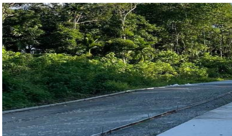
Gambar 4.11 Pembuatan Lean Concrete
