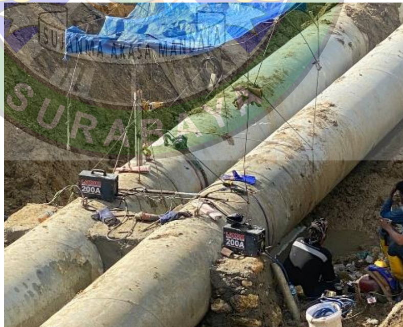
Gambar 4.21 Pengelasan Pipa
