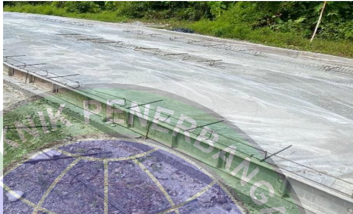
Gambar 4.12 Pemasangan plastik dan kerangka tulangan
