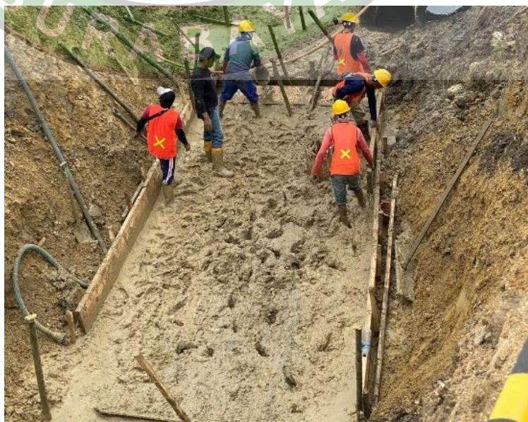
Gambar 4.19 Pengecoran Bagian dasar galian
