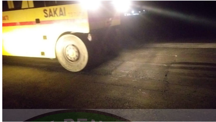
Gambar 4. 22 Pemadatan tire roller (Sumber : Dokumentasi Bangland 2022 )
