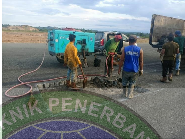
Gambar 4. 17 Pembongkaran aspal (Sumber : Dokumentasi Bangland 2022 )
