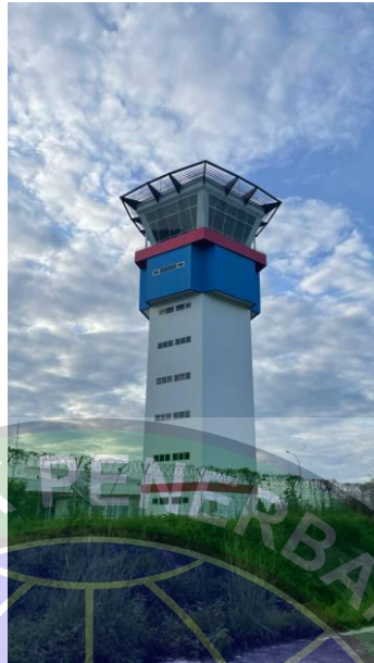
Gambar 4. 5 Tower ATC (Sumber : Dokumentasi pribadi,2023)
