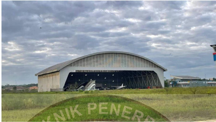
Gambar 4. 10 Hangar (Sumber : Dokumentasi pribadi,2023)
