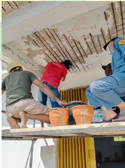
Gambar 5. 10 Perbaikan Gedung Power House
