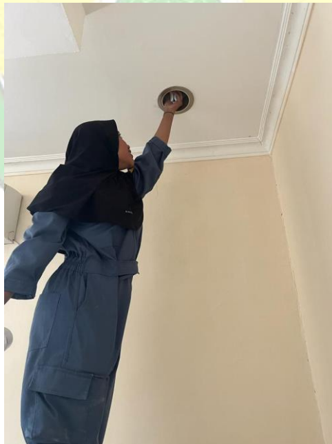
Gambar 5. 6 Pemasangan Lampu di Kantor TU
