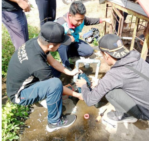
Gambar 5. 1 Perbaikan pompa di PKP-PK
