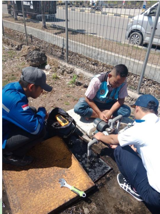
Gambar 5. 11 Perbaikan pompa air di Bangland
