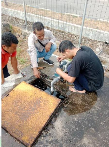
Gambar 5. 5 Perbaikan Pompa Air di Pokja
