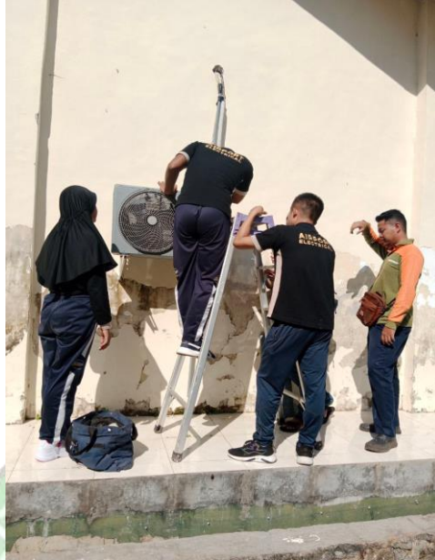
Gambar 5. 3 Perbaikan AC di Gedung Pokja
