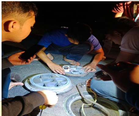
Pengecekan Lampu Insert
