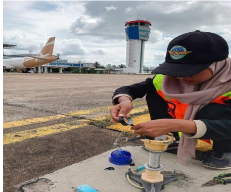
Pergantian Lampu Apron
