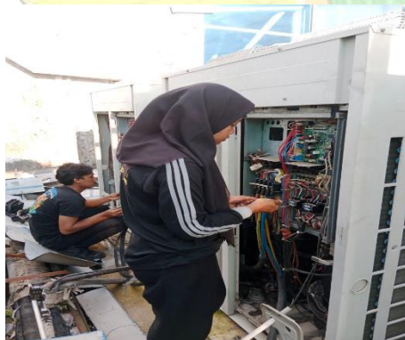
Pengecekan Komponen output AC
