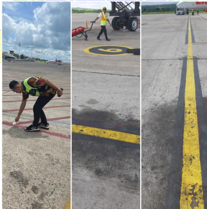
Gambar 4.16 Temuan FOD di Area Apron Bandara
