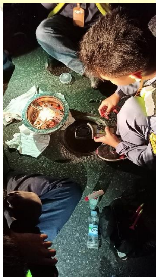
Perbaikan Lampu Runway Inset
