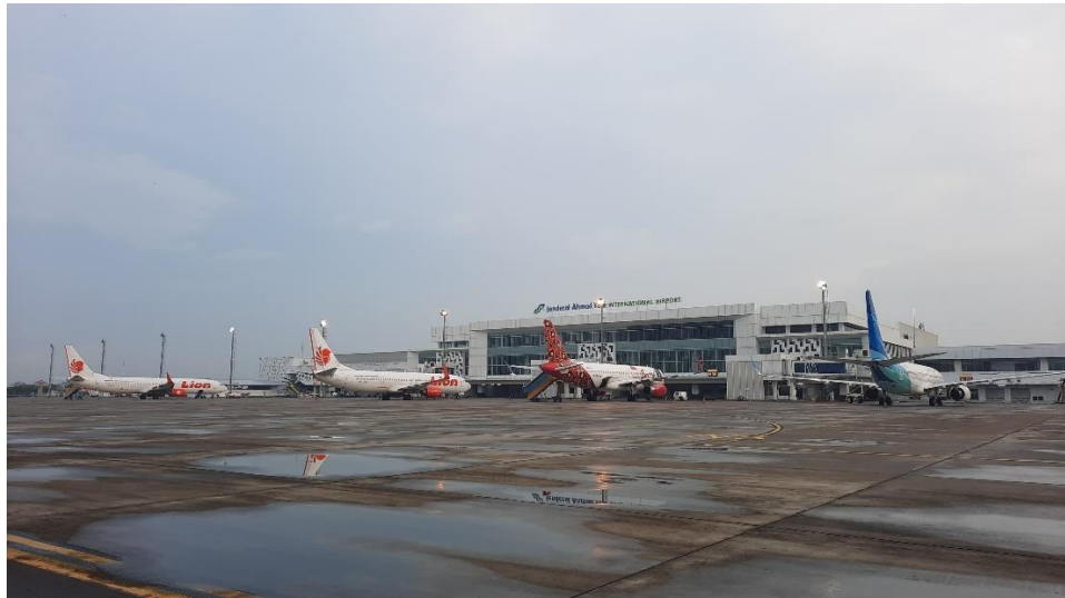
Gambar 3. 1 Apron Floodlight Sumber : Dokumentasi Penulis, 2023
