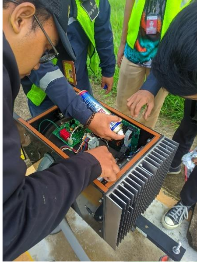
Perbaikan Modul PAPI 31
