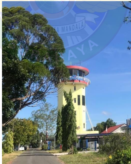
Gambar 2.9 Menara ATC Spesifikasi dari menara ATC
