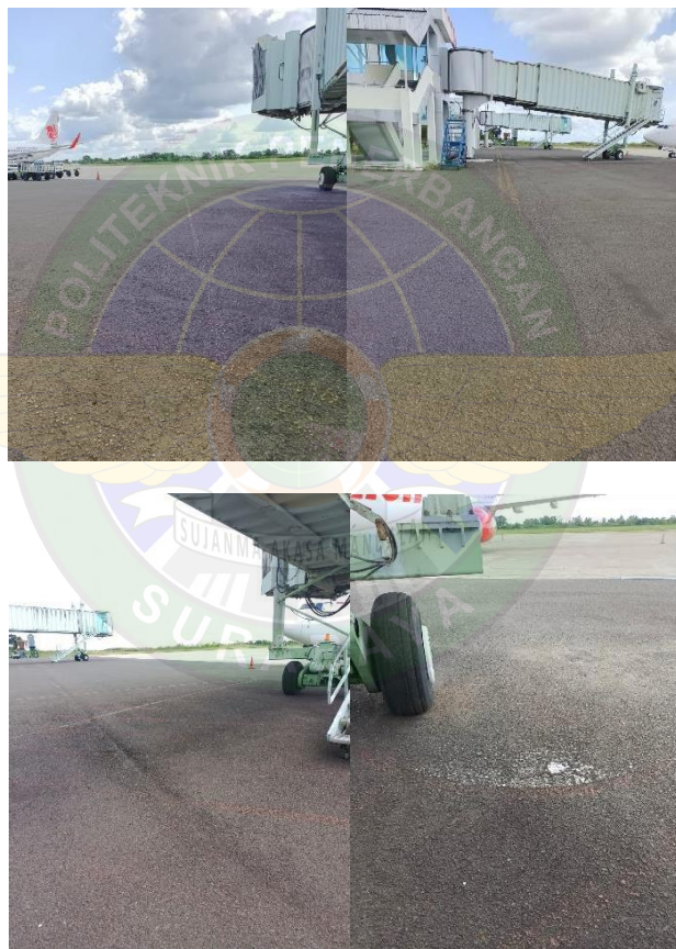
Gambar 3.1 Visabilitas Marka Yang Pudar
