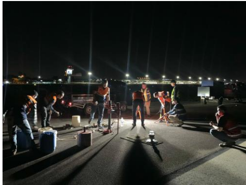
Proyek Pembuatan Shallowbase Untuk Lampu Runway Edge
