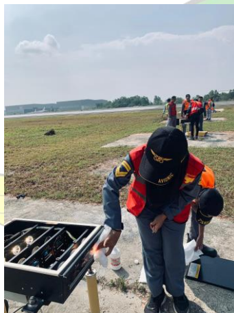
Pemeliharaan dan Pengecekan Rutin Lampu PAPI
