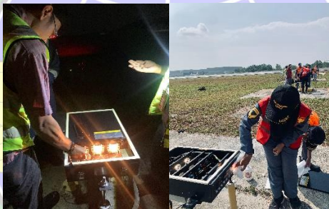
Gambar 4. 1 Pengecekan Rutin Kondisi Lampu dan Sudut PAPI Sumber : Dokumentasi OJT, 2023
