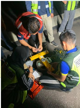
Pemasangan Lampu Runway Edge Insert
