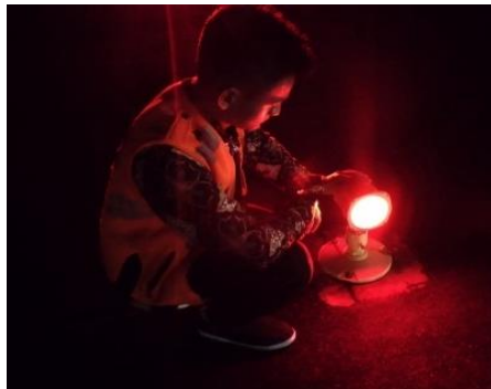
Gambar 2. 7 Lampu Stopway Sumber: PT Bandara Internasional Batam
