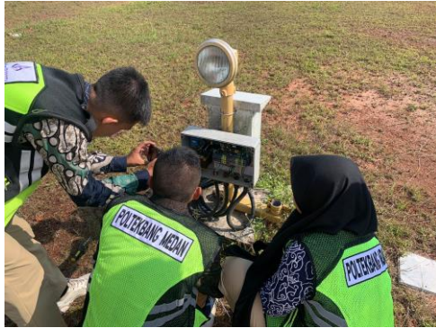
Perbaikan Modul SQFL di Runway 04
