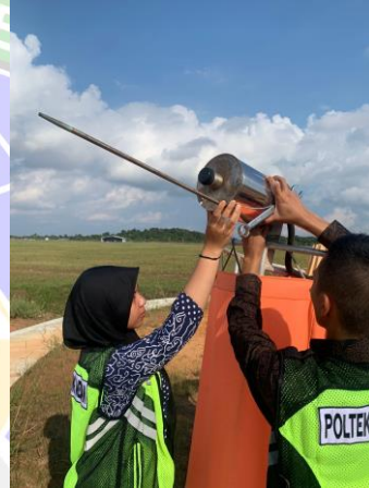
Penggantian Cone Windshock dan Lampu pada Windshock
