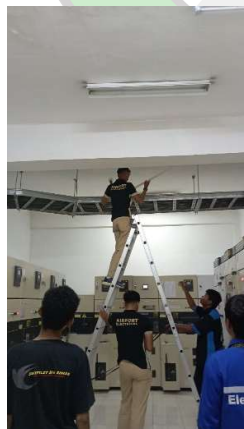
Penggantian Lampu TL Ruang Panel TM
