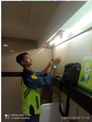
Penggantian Lampu TL Toilet Terminal
