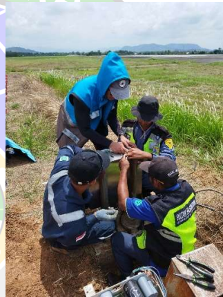
Pemasangan Master Control SFL PALS-21
