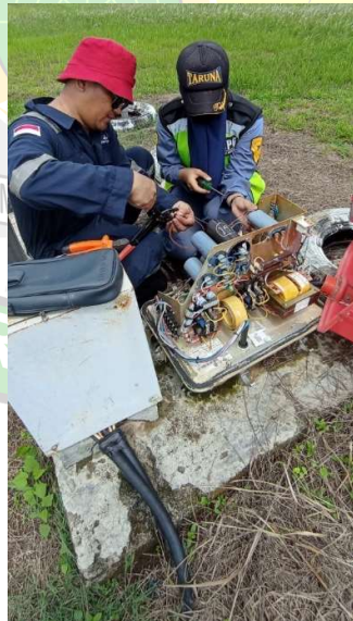
Gambar 4.27 Pengecekan dan Pengaturan Kabel Kontrol Antar FCU Sumber : Dokumentasi Pribadi
