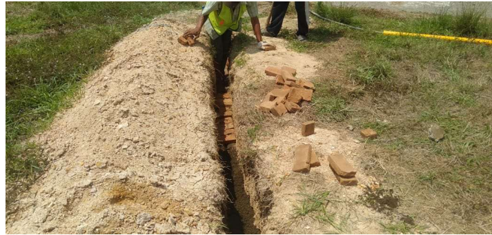
Gambar 4.26 Penimbunan Galian Jalur Kabel Power Sumber : Dokumentasi Pribadi
