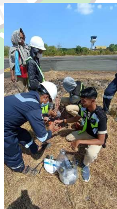
Penggelaran Kabel FL2XCY Taxiway Edge Light
