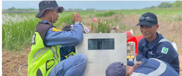
Gambar 4.29 Pemasangan Master Control Sumber : Dokumentasi Pribadi
