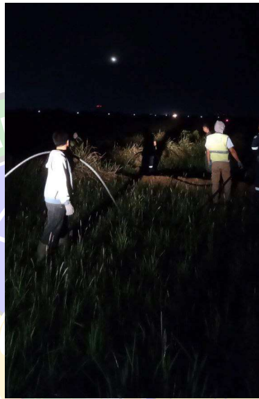
Gambar 4.24 Penggelaran Kabel Power Sumber : Dokumentasi Pribadi
