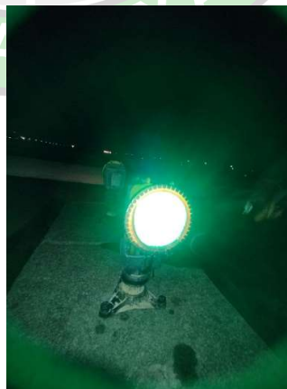
Gambar 4.4 Threshold Light 31 Sumber : Dokumentasi Pribadi
