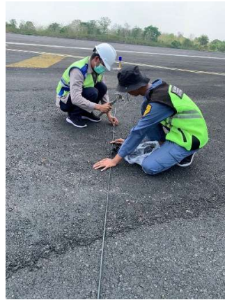
Penggelaran Kabel Sekunder Taxiway Edge Light
