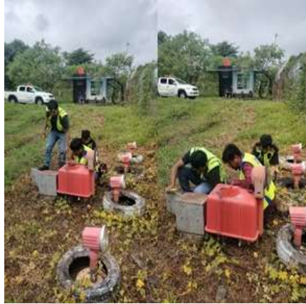
Gambar 4.22 Perbaikan Lanjutan SFL Sumber : Data Unit Listrik
