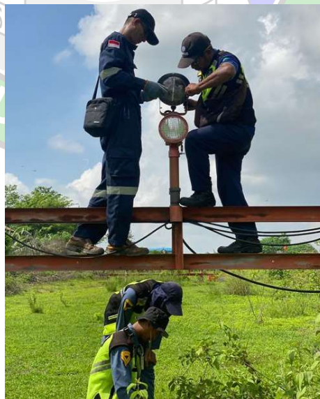
Gambar 4.31 Penggantian Lampu SFL Sumber : Dokumentasi Pribadi
