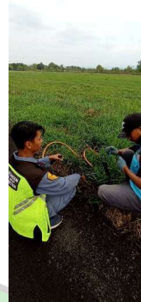
Penggelaran Kabel FL2XCY Runway Edge Light
