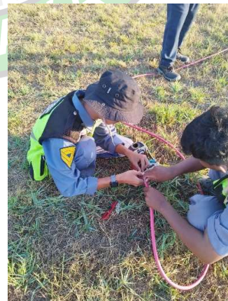
Penggelaran Kabel FL2XCY Taxiway Edge Light
