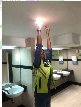
Penggantian Lampu Pijar Toilet Terminal
