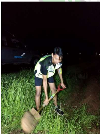
Penggalian Jalur Kabel FL2XCY
