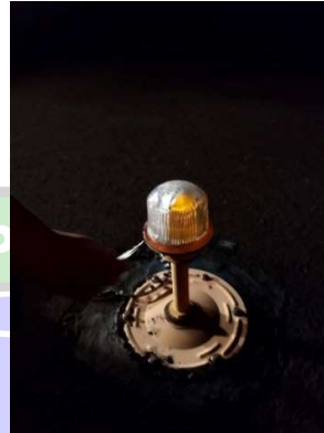
Gambar 4.5 Runway Edge Light 03-21 Sumber : Dokumentasi Pribadi
