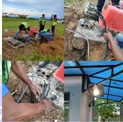
Gambar 4.21 Perbaikan Awal SFL
