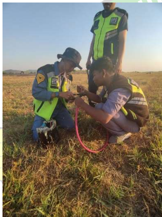
Penggelaran Kabel FL2XCY Taxiway Edge Light
