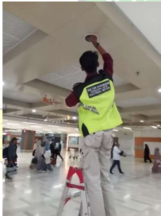
Penggantian Lampu Pijar Ruang Check-In
