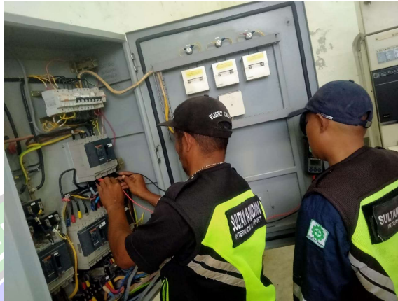
Gambar 4.28 Penyambungan Kabel Power di SST-4 Sumber : Dokumentasi Pribadi
