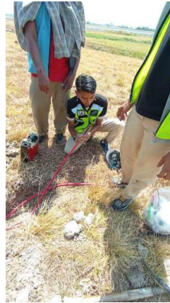
Penggelaran Kabel FL2XCY Taxiway Edge Light
