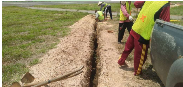
Gambar 4.23 Penggalian Jalur Kabel Power Sumber : Dokumentasi Pribadi
