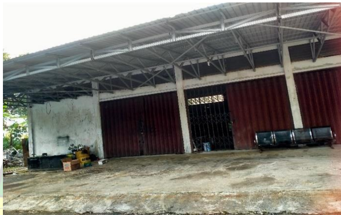
Gambar 2. 25 Gedung Workshop (A2B)
