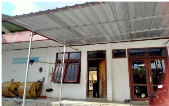
Gambar 2. 24 Bangunan Ruang Listrik dan CCR
