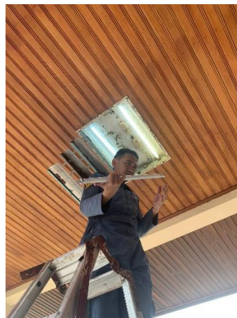
Penggantian Lampu TL Pada Terminal
