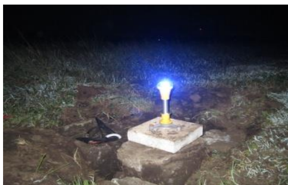
Gambar 2. 12 Turning Area Light Sumber: Bandara Husein Sastranegara
