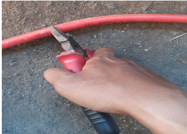
Gambar 4. 7 Cara untuk memotong kabel FL2XCY
