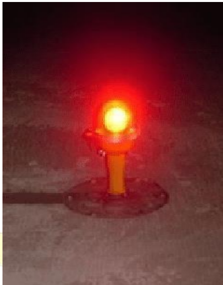
Gambar 2. 13 Stopway Light Sumber: Penulis
