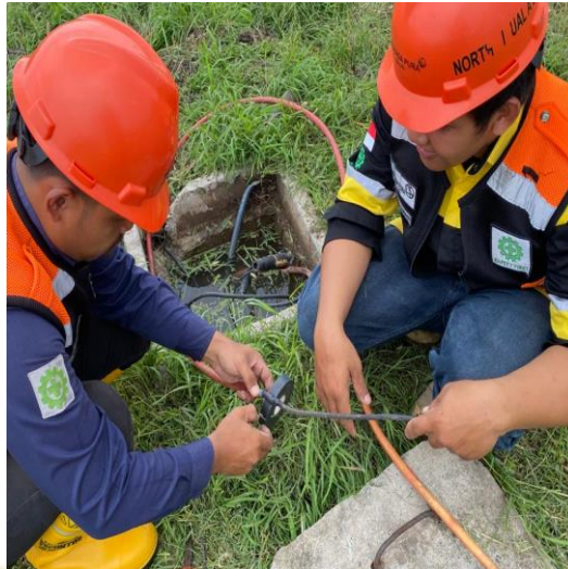
Gambar 4. 9 Penyambungan kabel FL2XCY
