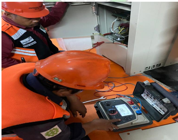
Gambar 4. 13 Pengukuran ulang Megger di gardu T4
