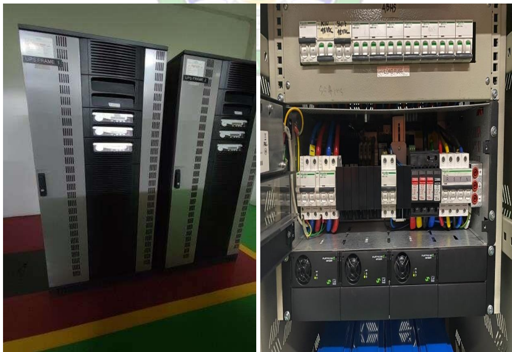
Gambar 2. 41 UPS dan Converter Sumber: Penulis
