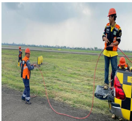
Gambar 4. 8 Penggelaran kabel FL2XCY di lapangan
