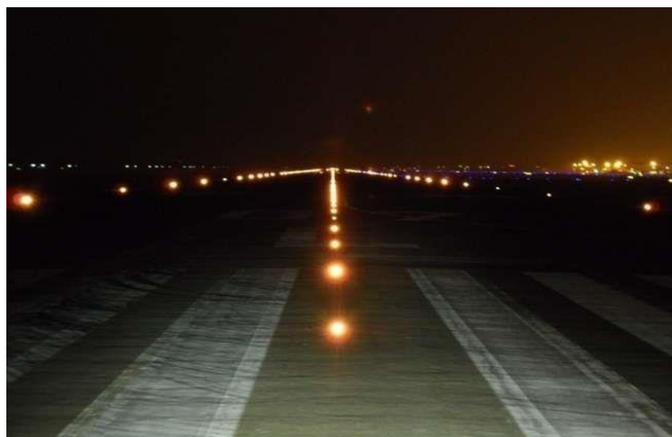
Gambar 2. 11 Runway Centerline Light Sumber: Penulis
