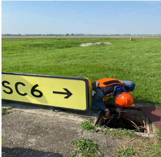
Gambar 4. 4 Pengecekan pit trafo
