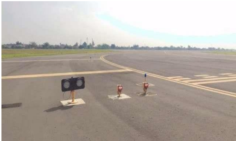
Gambar 2. 17 Stopbar Light Sumber: Penulis
