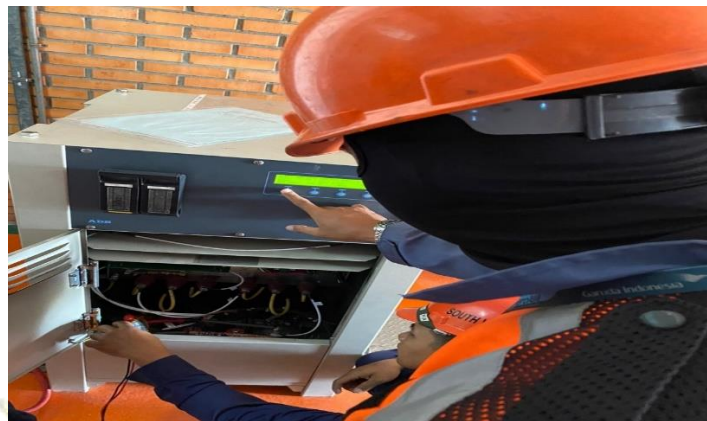
Gambar 4. 14 Test nyala CCR gardu T4
