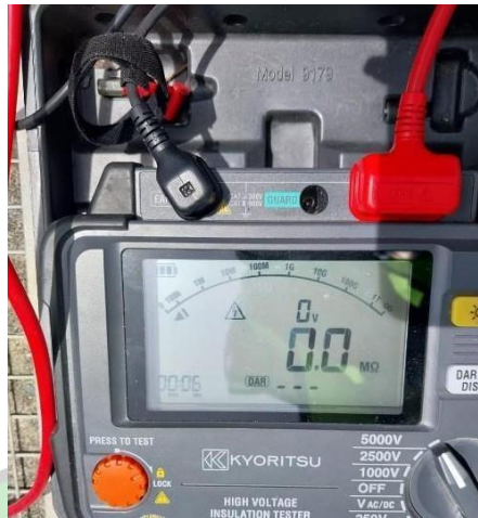
Gambar 4. 5 Pengecekan tahanan isolasi kabel
