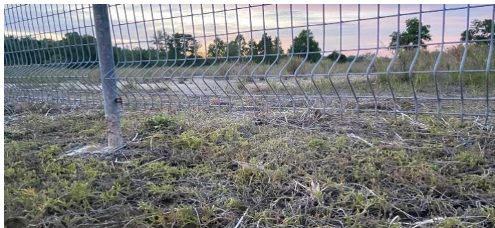
Gambar 3.5 Parimeter di runway 06
