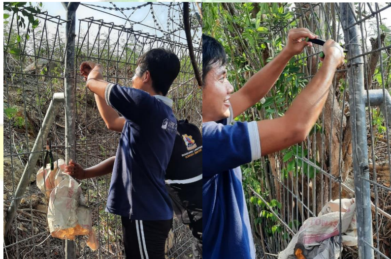
Gambar 4.24 Proses Perbaikan Pagar Terlepas
