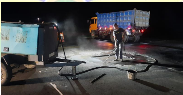
Gambar 4.17 Pembersihan lokasi penambalan ( patching ) dengan compressor
