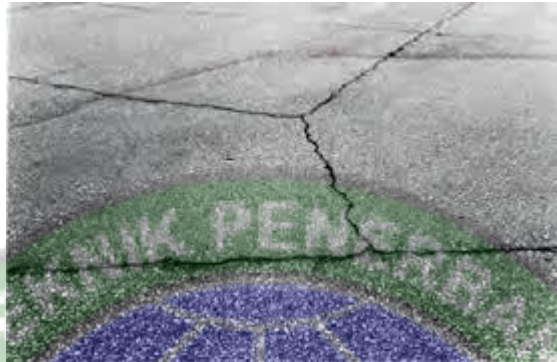
Gambar 3. 1 Retak Memanjang dan Melintang
