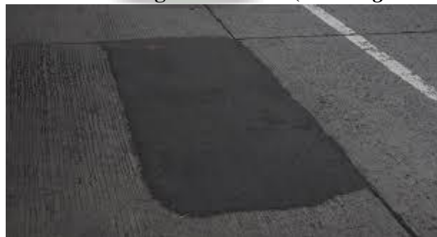
Gambar 3. 10 Tambahan dan Galian Utilitas
