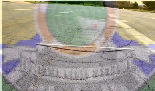
Gambar 3. 11 Lendutan Di Jalur Roda
