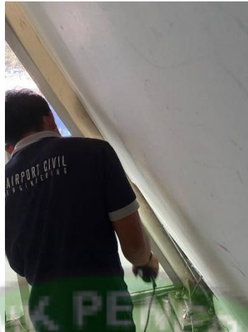
Gambar 4. 14 Memotong Plafon Yang Rusak
