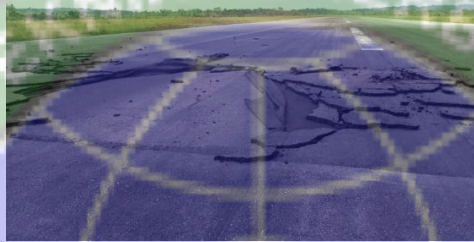
Gambar 3. 8 Aspal Yang Mengelupas
