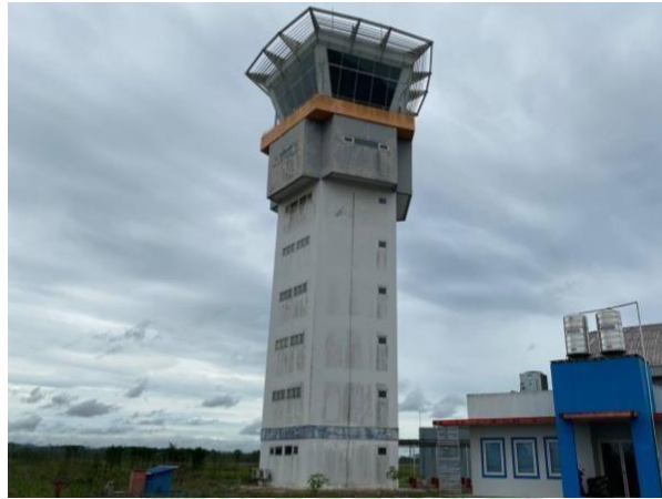
Gambar 4. 7. Bangunan Pengatur Lalu Lintas (ATC Tower)
