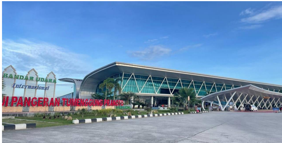
Gambar 2. 1. Terminal Penumpang Aji Pangeran Tumenggung Pranoto (Sumber: Dokumentasi penulis tahun 2024)
