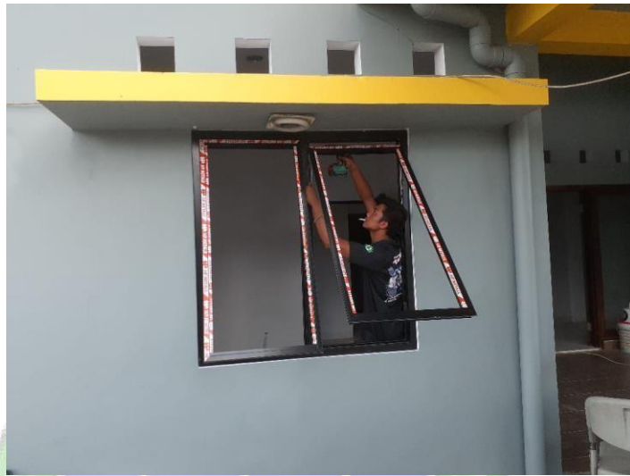
Gambar 4. 26 Pemasangan Kusen Jendela (Sumber : Dokumentasi Penulis, 2024)
