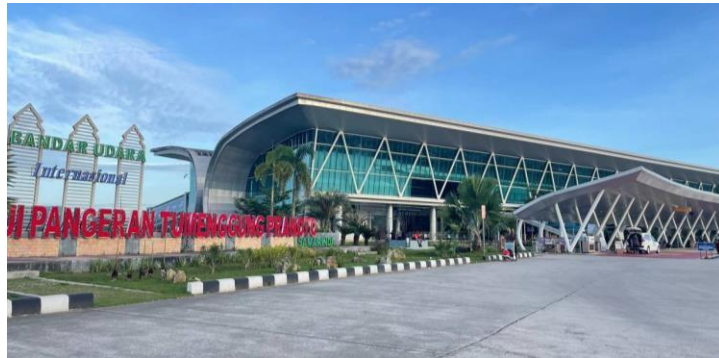
Gambar 4. 4. Gedung Terminal Bandar Udara Aji Pangeran Tumenggung Pranoto, Samarinda (Sumber : Dokumentasi Penulis, 2024)
