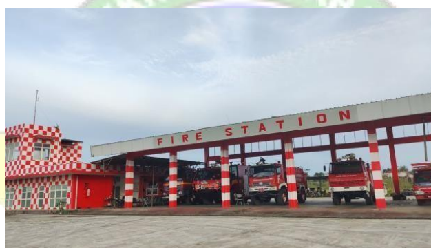
Gambar 4. 10. Bangunan PKP-PK (Sumber : Dokumentasi Penulis, 2024)
