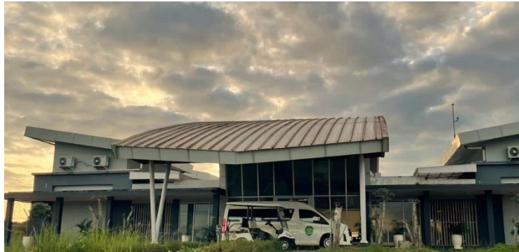
Gambar 4. 5. Terminal VVIP (Sumber : Dokumentasi Penulis, 2024)
