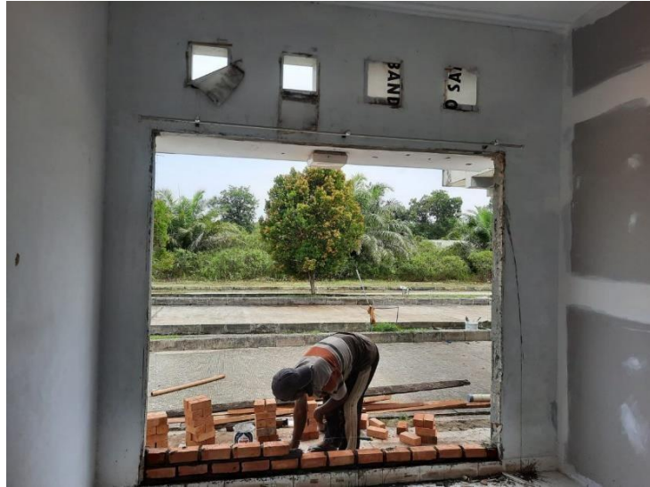
Gambar 4. 22 Pekerjaan Partisi (Sumber : Dokumentasi Penulis, 2024)
