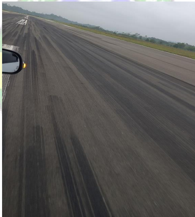
Gambar 4. 20 Kondisi Rubber Deposit (Sumber : Dokumentasi Penulis, 2024)
