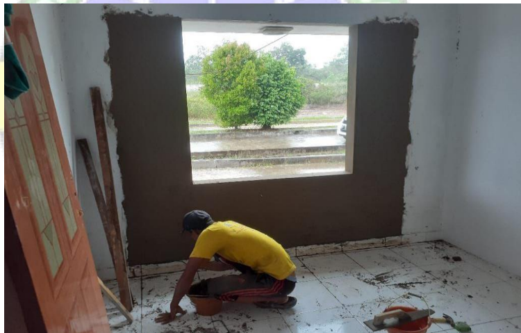
Gambar 4. 23 Pekerjaan Plesteran (Sumber : Dokumentasi Penulis, 2024)
