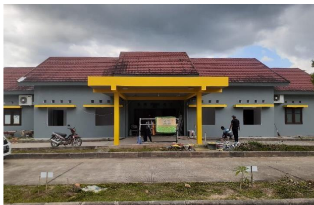
Gambar 4. 25 Finish Pengecatan Dinding Mess (Sumber : Dokumentasi Penulis, 2024)
