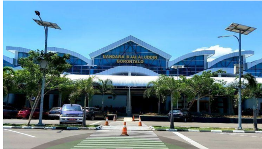
Gambar 4. 5 Terminal Bandar Udara Djalaluddin, Gorontalo (Sumber: Olahan Penulis, Tahun 2023)
