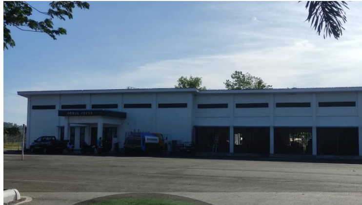
Gambar 4. 7 Gedung Power House (Sumber: Olahan Penulis, Tahun 2023)
