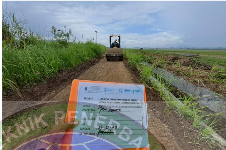
Gambar 4. 20 Pekerjaan Pemadatan Tanah Subgrade (Sumber: Dokumentasi Penulis, Tahun 2023)
