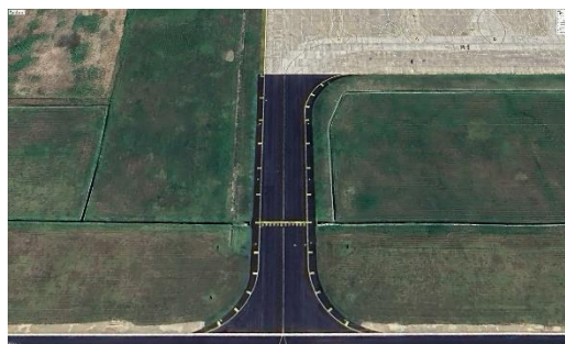
Gambar 4. 3 Tampak Atas Taxiway Bandar Udara (Sumber: Google Earth Pro, Tahun 2023)
