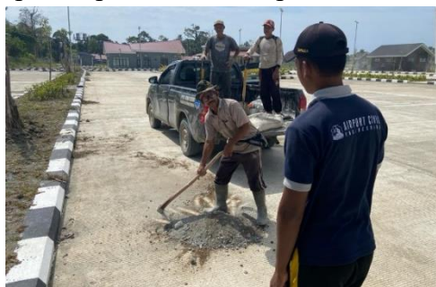
Gambar 4. 26 Pembuatan bahan cor pondasi (Sumber: Olahan Penulis,2023)
