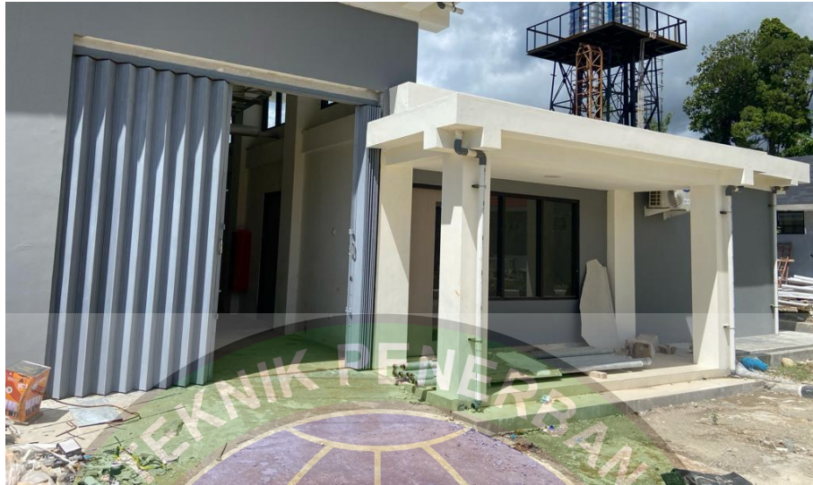
Gambar 4. 4 Gedung Power House Bandara Mentawai (Sumber: Olahan Penulis, 2024)
