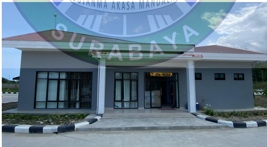
Gambar 4. 5 Gedung Administrasi Bandara Mentawai (Sumber: Olahan Penulis, 2024)
