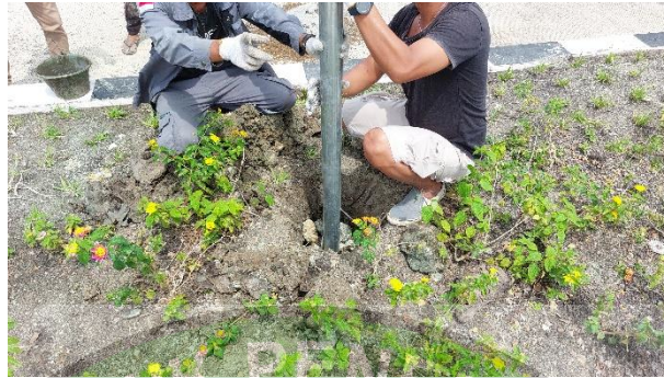
Gambar 4. 27 Peletakan rambu petunjuk (Sumber: Olahan Penulis,2023)
