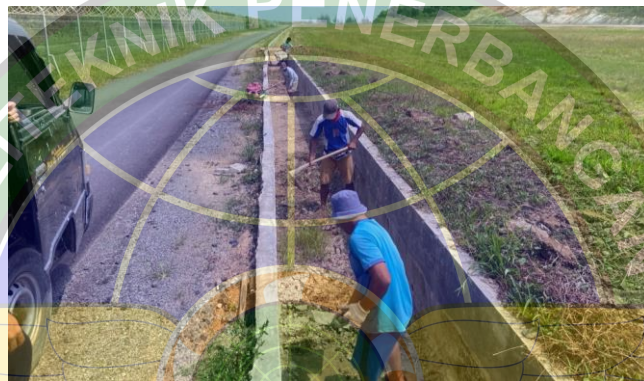
Gambar 4. 17 Pembersihan Saluran Drainase (Sumber: Olahan Penulis, 2023)
