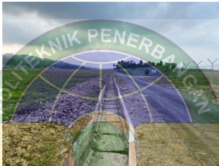
Gambar 4. 19 Kondisi Saluran Setelah Pembersihan (Sumber: Olahan Penulis, 2023)
