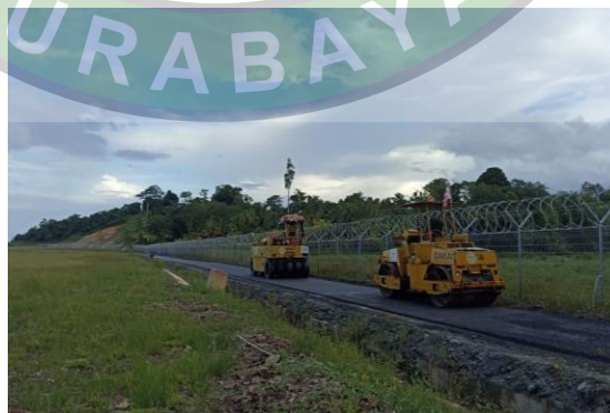
Gambar 4. 31 Pemadatan dengan Pneumatic Tire Roller (Sumber: Olahan Penulis, Tahun 2023)
