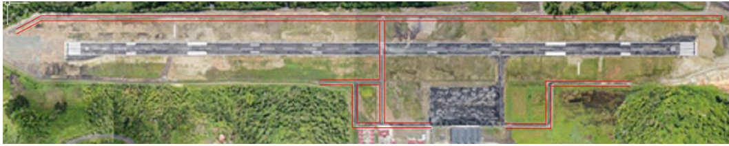
Gambar 4. 11 Lokasi Pekerjaan Asphalt Trated Base (ATB) (Sumber: Olahan Penulis, Tahun 2023)
