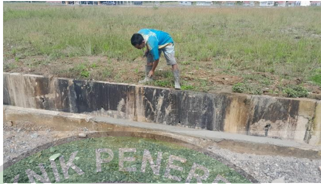
Gambar 4. 40 Pembersihan Sekitar Area Drainase (Sumber: Olahan Penulis, Tahun 2023)
