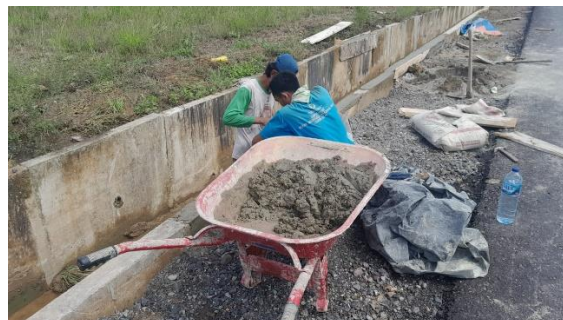
Gambar 4. 42 Pembuatan Bekisting (Sumber: Olahan Penulis, Tahun 2023)
