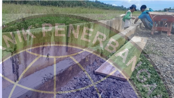
Gambar 4. 39 Kayu/Papan Bekisting (Sumber: Olahan Penulis, Tahun 2023)
