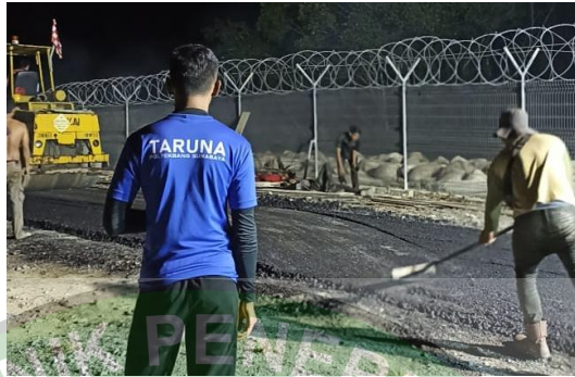
Gambar 4. 30 Pemadatan Menggunakan Tandem Roller (Sumber: Olahan Penulis, Tahun 2023)
