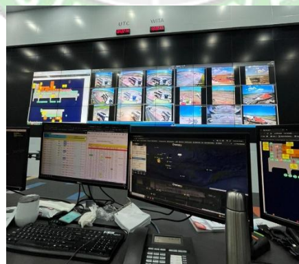
Gambar 3. 17 Tampilan CCTV di ruang AOCC
