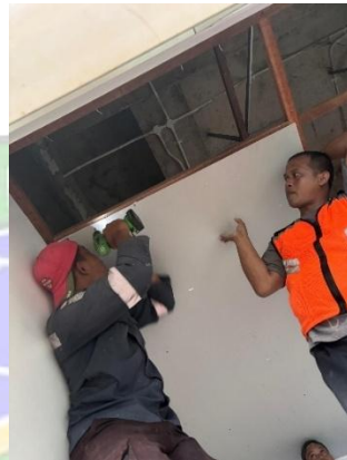
Gambar 4. 4.15 Pemasangan panel plafon yang baru
