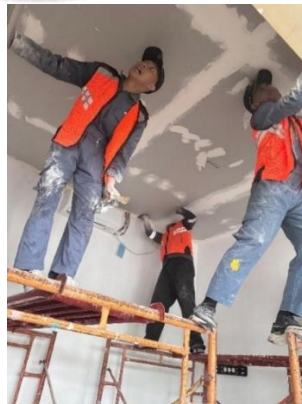
Gambar 4.4.16 Penghalusan sambungan plafon
