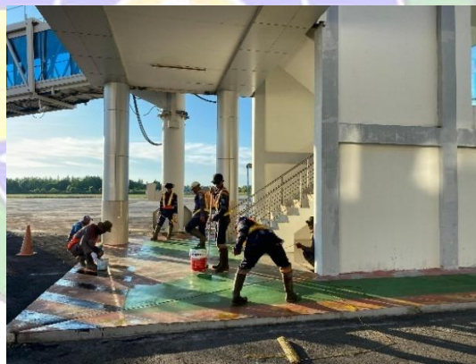
Gambar 4. 4.6 Pengecatan Marka
