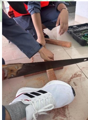
Gambar 4. 4.12 Pemotongan balok untuk membuat tulangan baru
