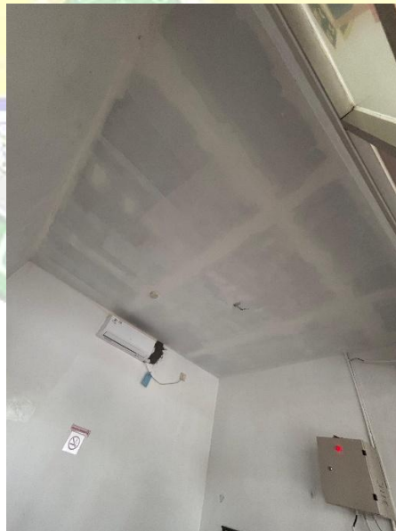
Gambar 4.4.8 pemasangan plafon
