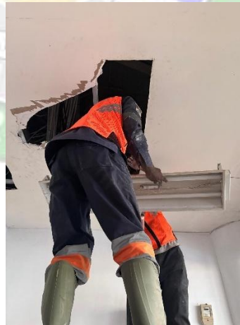
Gambar 4.4.10 Pembongkaran Plafon yang rusak
