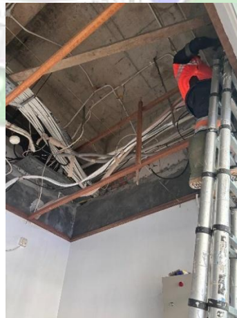
Gambar 4. 4.14 Tulangan baru menggunakan kayu
