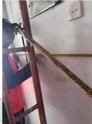
Gambar 4. 4.11 Pengukuran ketinggian plafon
