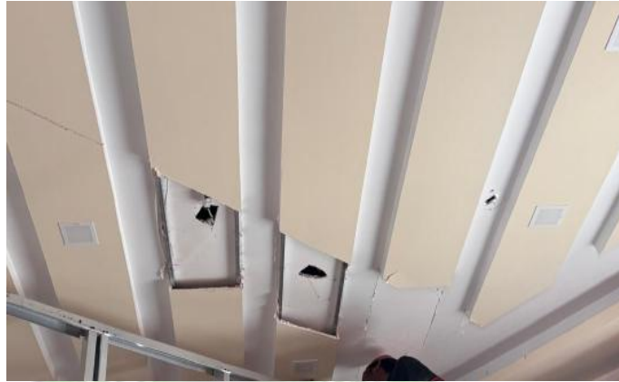
Gambar 4.47 Pembongkaran plafon
