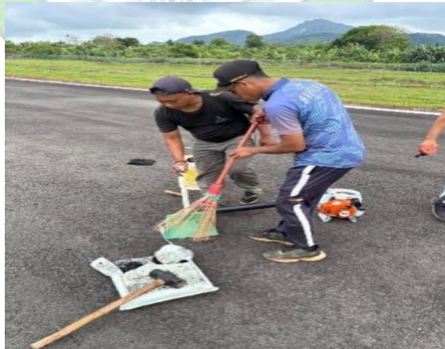
Gambar 4.25 Pembersihan sisa material yang dibongkar
