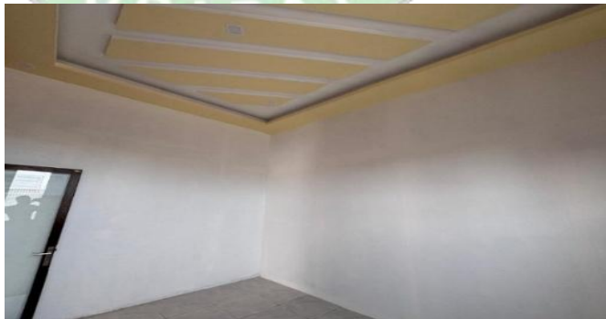
Gambar 4.52 Pengecatan dinding dan plafon
