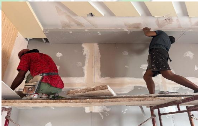
Gambar 4.31 Renovasi ruangan administrasi
