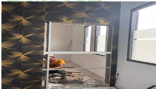
Gambar 4.50 Pemasangan kusen pintu
