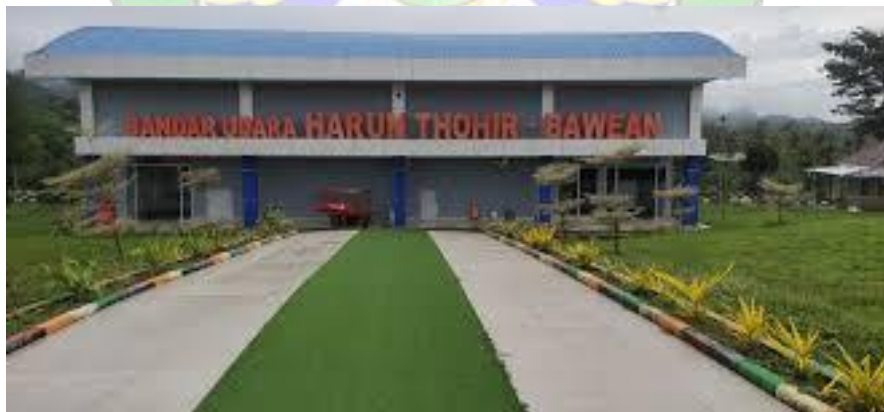
Gambar 2.1 Terminal Bandar Udara Kelas III Harun Thohir Bawean
