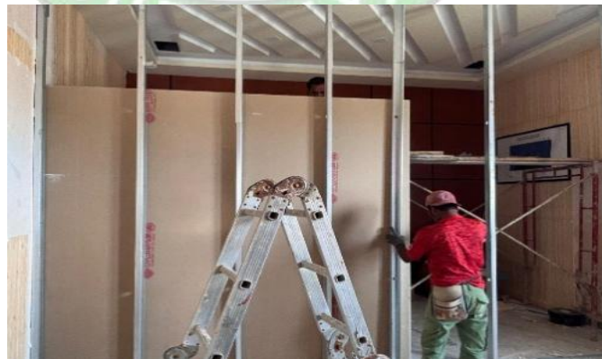
Gambar 4.48 Pemasangan hollow
