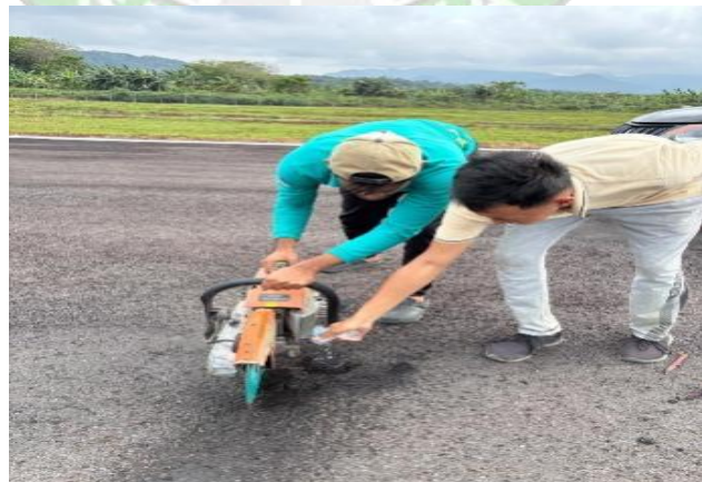
Gambar 4.23 Pemotongan aspal menggunakan concrete cutter
