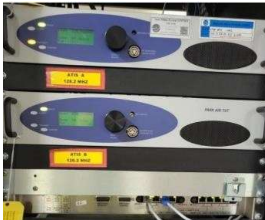
Gambar 3. 5 Radio TX ATIS Merk PAE 1 Sumber : Dokumentasi Penulis
