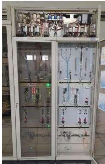
Gambar 3. 13 Rak Radar MSSR Merk ELDIS Sumber: Dokumentasi Penulis
