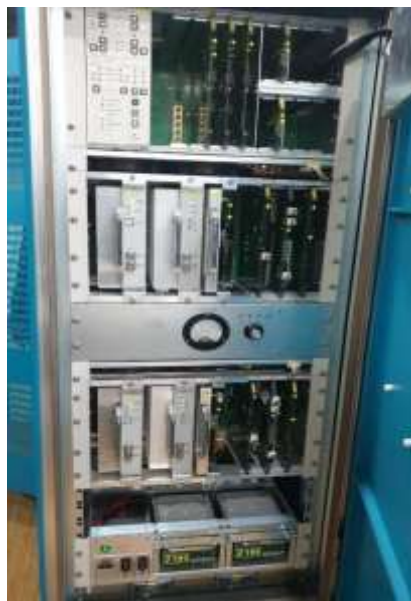
Gambar 3. 7 Localizer Merk Normarc Sumber: Dokumentasi Penulis
