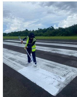
Gambar 4. 29 Proses Pengecatan
