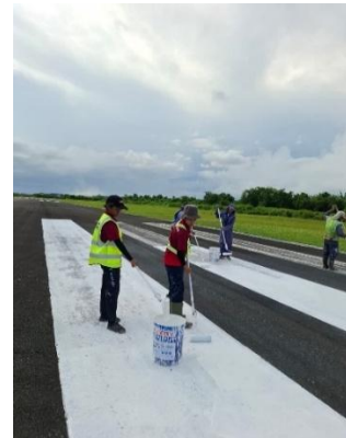
Gambar 4. 31 Proses Pengecatan
