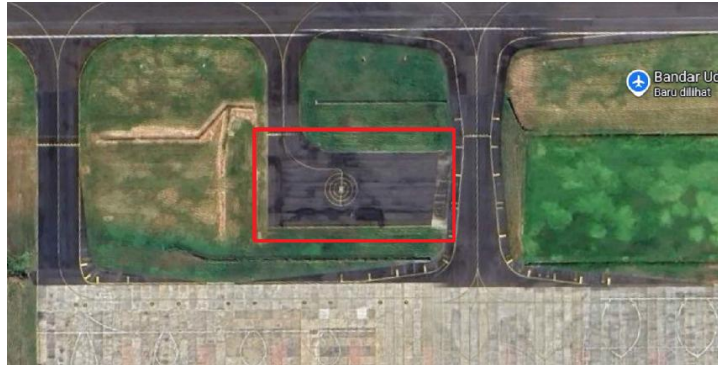
Gambar 4. 13 Heliport Bandar Udara Internasional Banyuwangi Sumber : Google Earth, Tahun 2024
