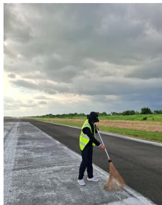
Gambar 4. 28 Proses Pembersihan Permukaan Marka
