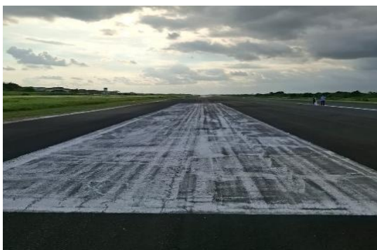
Gambar 4. 17 Marka Aiming Point Sebelum Perawatan Sumber : Dokumentasi Pribadi, 2025
