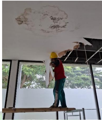
Gambar 4. 42 Proses Pembongkaran Plafon
