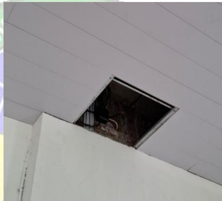
Gambar 4. 46 Pembuatan Service Hatch
