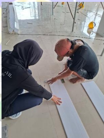
Gambar 4. 43 Proses Pemotongan PVC
