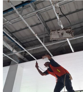
Gambar 4. 45 Pemasangan Sekrup
