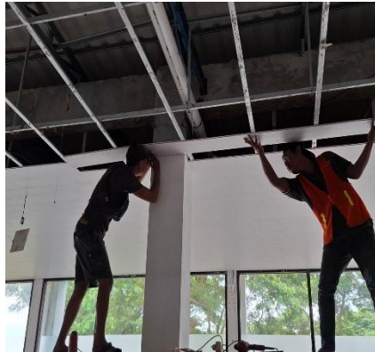
Gambar 4. 44 Proses Pemasangan PVC
