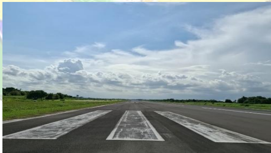
Gambar 4. 16 Marka Touchdown Sebelum Perawatan Sumber : Dokumentasi Pribadi, 2025
