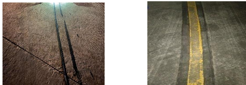
Gambar 4. 11 Kondisi Marka Apron Sebelum Dilakukan Pengecatan
