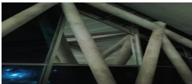
Gambar 4. 39 Setelah Kaca Terpasang
