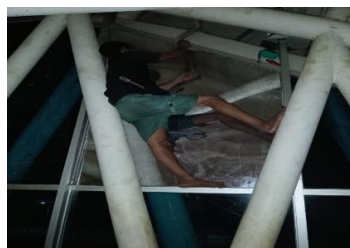
Gambar 4. 38 Pemasangan Kaca dibantu dengan Alat
