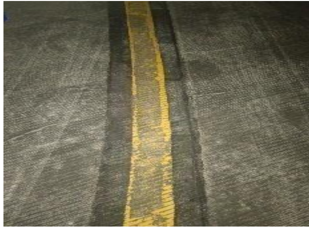
Gambar 4.23 (Kondisi Marka Apron Sebelum Pemeliharaan)
