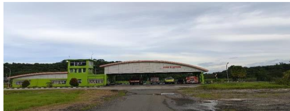
Gambar 4. 6 Gedung Fire Station Bandara Kalimarau (Sumber: Dokumentasi Penulis, Tahun 2025)
