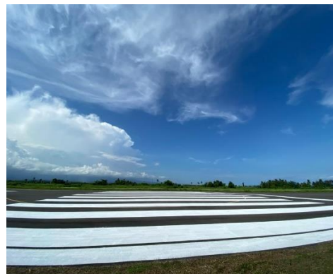
Gambar 4. 19 Dokumentasi, Proses campuran air dan cat dan mengecat marka Thershold
