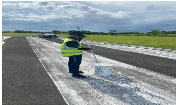
Gambar 4. 19 Dokumentasi, Proses campuran air dan cat dan mengecat marka Thershold
