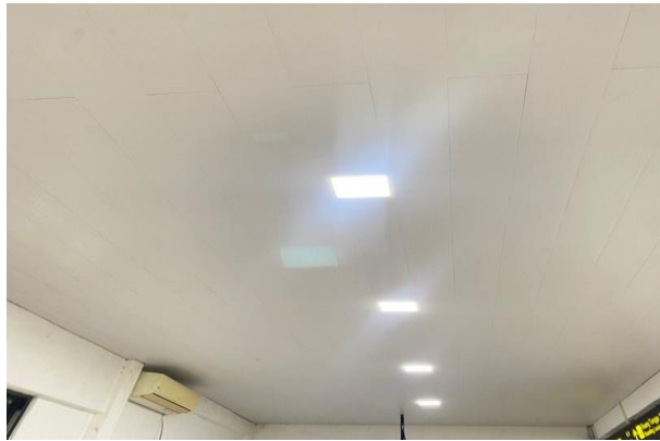
Gambar 4. 29 Pelaksanaan Perbaikan Atap, dan Hasil perbaikan Plafon di Ruang SCP
