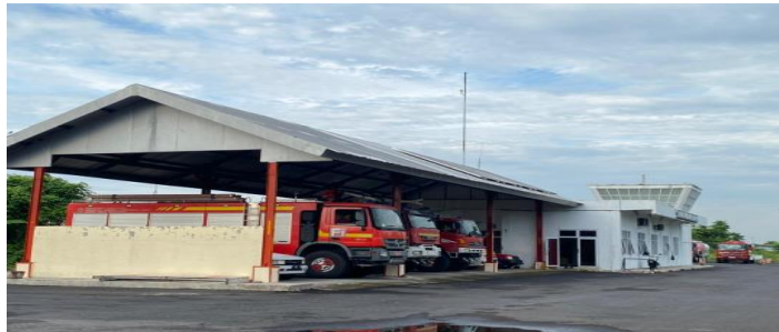
Gambar 4. 6 Gedung Fire Station Bandara Banyuwangi (Sumber: Dokumentasi Penulis, Tahun 2026)
