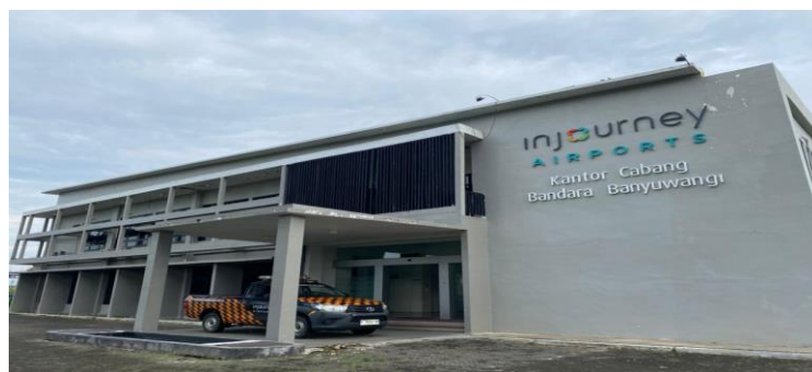
Gambar 4. 10 Gedung Administrasi (Sumber: Dokumentasi Penulis 2026)
