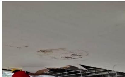
Gambar 4. 28 Pembongkaran Plafon (Sumber: Dokumentasi Penulis, Tahun 2025)
