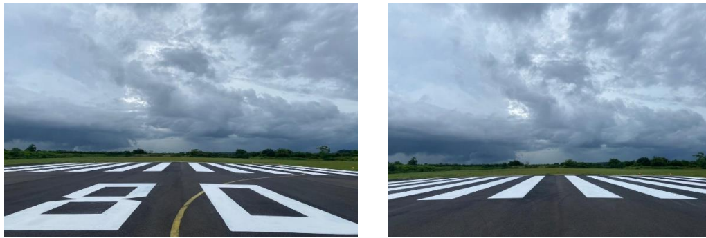
Gambar 4. 20 (Kondisi Marka Threshold setelah Pemeliharaan Marka Threshold )
