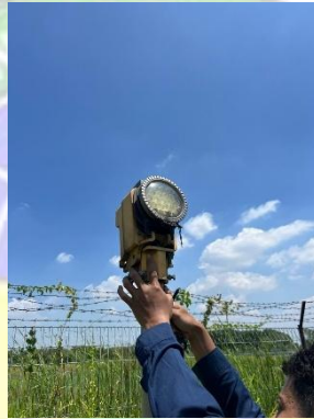
Gambar 4. 7 setelah perbaikan lampu approach light kembali normal
