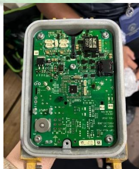
Gambar 4. 6 Ganti modul Approach light pada Runway 28 di bar 6
