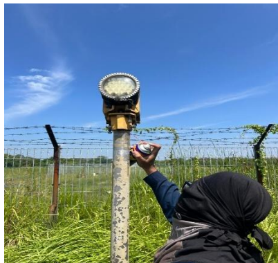
Gambar 4. 1 pemeliharaan lampu Approach light di runway 28
