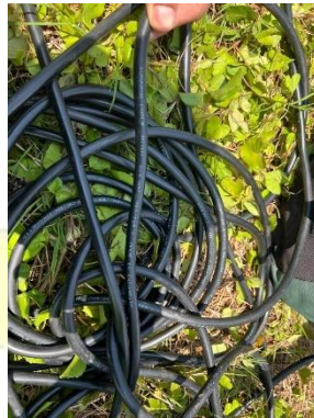
4. 4 Ganti kabel sekunder type NYY
