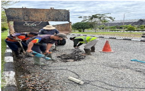
Gambar 4.7 Pembongkaran Titik Kerusakan (Sumber : Olahan Penulis,2025)
