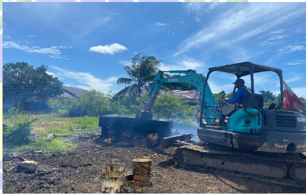
Gambar 4.6 Pembakaran Material (Sumber : Olahan Penulis,2025)
