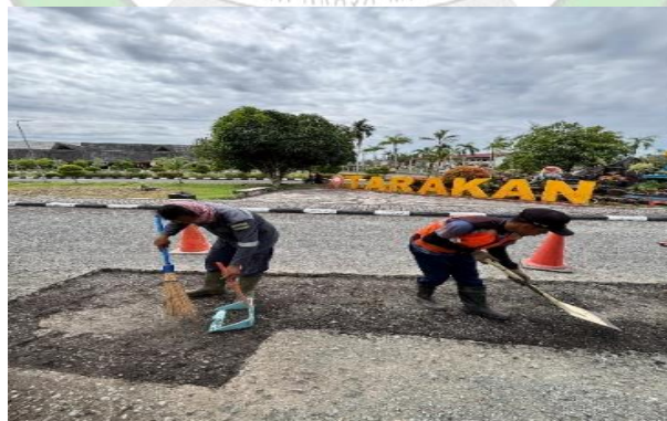
Gambar 4.8 Pembersihan Sisa Material (Sumber : Olahan Penulis,2025)
