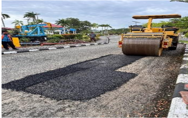
Gambar 4.11 Pemadatan Menggunakan Tandem Roller
