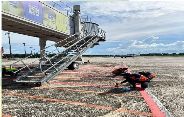
Gambar 4.3 Pengecatan Marka (Sumber : Dokumentasi Penulis,2025)
