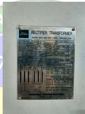
Gambar 3.22 Spesifikasi Trafo Eksitasi
