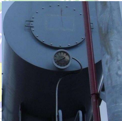
Gambar 3.19 Indikator Level Minyak
