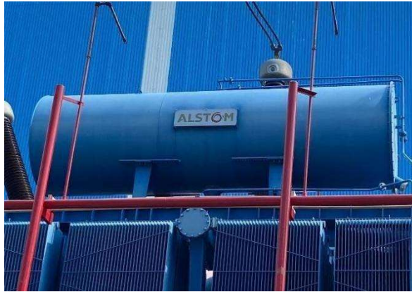
Gambar 3.14 Tangki dan Konservator trafo
