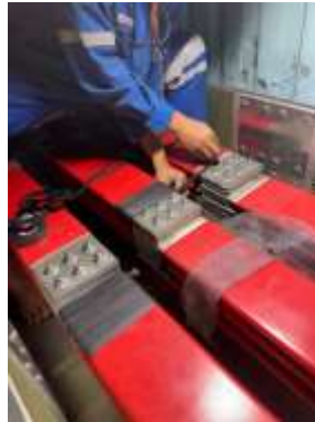
Gambar 4. 9 Pemasangan Busbar dan Sistem Isolasi
