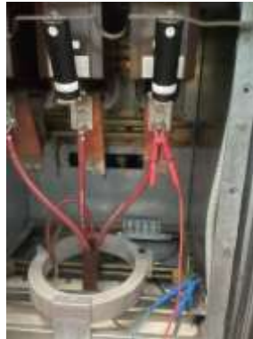
Gambar 4. 10 Pengujian pada Busbar
